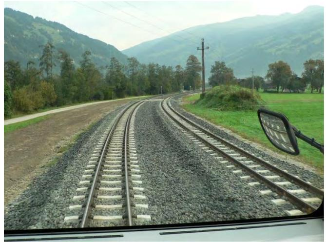
Links: Mit schlanken Weichen, die mit 40 km/h in die Ablenkung befahrbar sind, ausgebauter „Schneller Kreuzungsbahnhof“ der Pinzgaubahn. Rechts: Zweigleisiger Abschnitt der Zillertalbahn für die beim Taktfahrplan notwendigen „fliegenden Kreuzungen“. Fotos: Otfried Knoll
