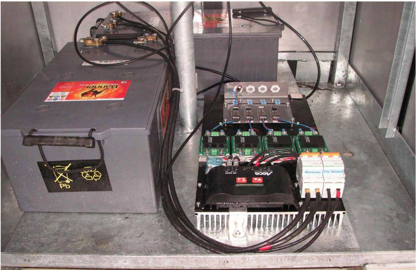
E-Bike und Solar-Lademodul mit integriertem Umrichter und Pufferbatterie.
